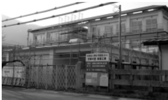
建設中の特別養護老人ホーム
