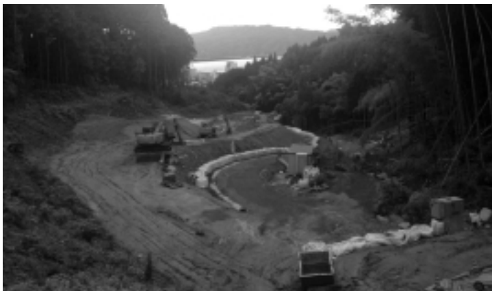
建設中の辻川砂防ダム
