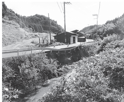
外垣線の道路復旧
