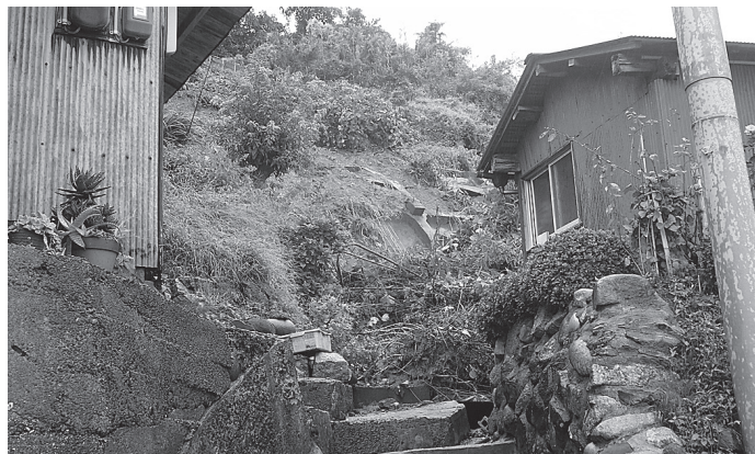
台風18号の被害状況
