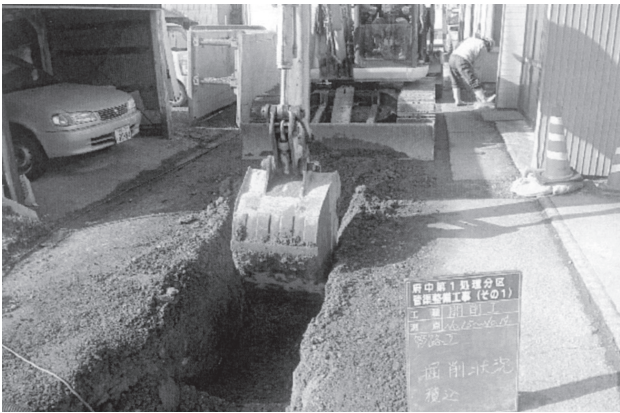
府中地区の下水道工事
