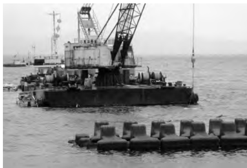
工事が進む養老大島地区
