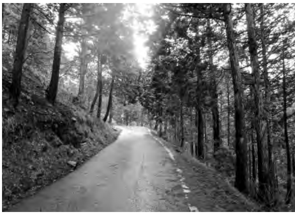
整備された市道
