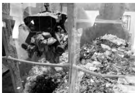
宮津市清掃工場のごみピット
