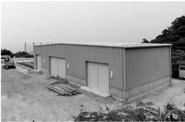
波見に建設中の農林バイオマス3号関連施設
