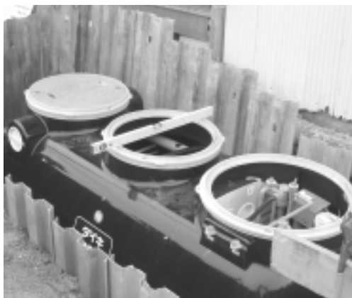
浄化槽設置工事
