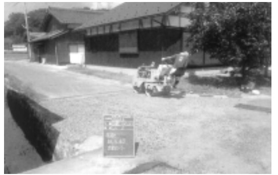
道路補修の様子
