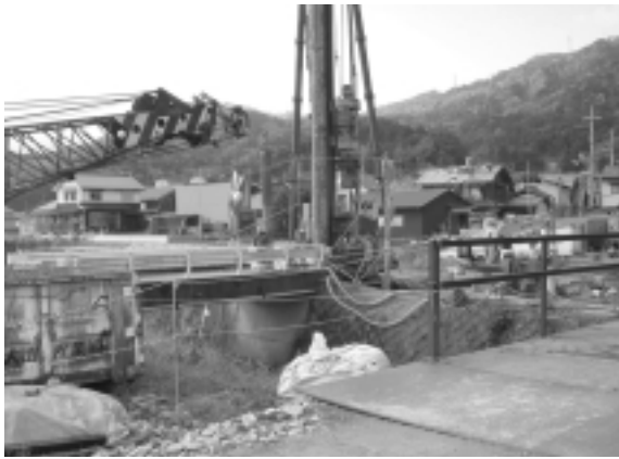
京都府から受託した善光橋架け替え工事
