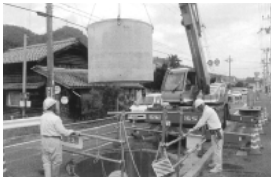
下水道工事の様子
