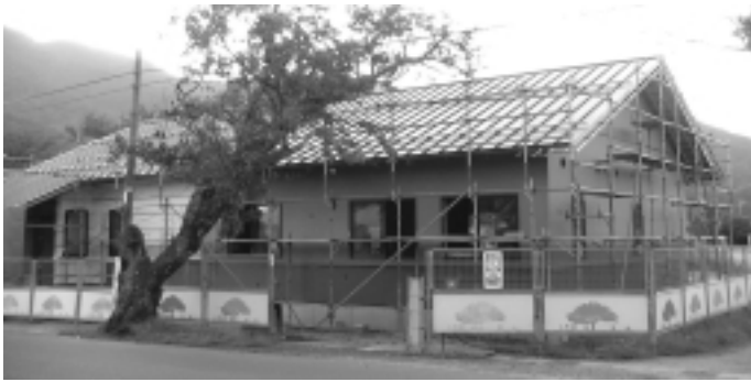
工事が進む由良診療所
