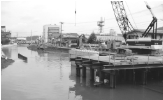
大手川改修に伴う中橋架け替え工事
