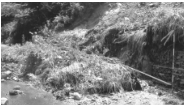
急がれる災害復旧工事
