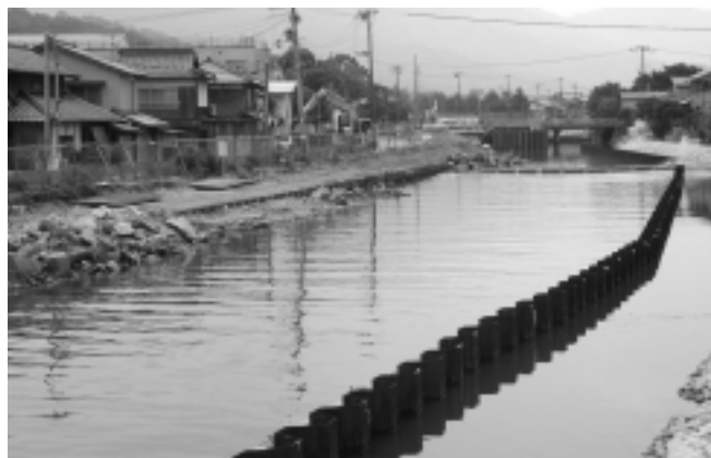
大手川改修工事の様子
