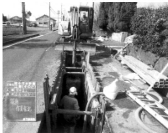
下水道工事の様子
