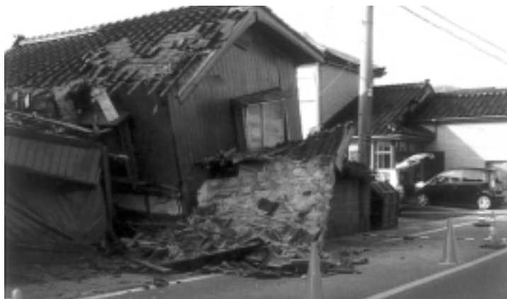
新潟県中越沖地震で倒壊した木造住宅
