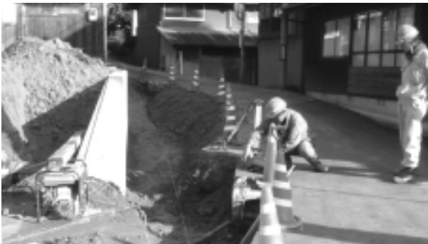
道路改良工事風景
