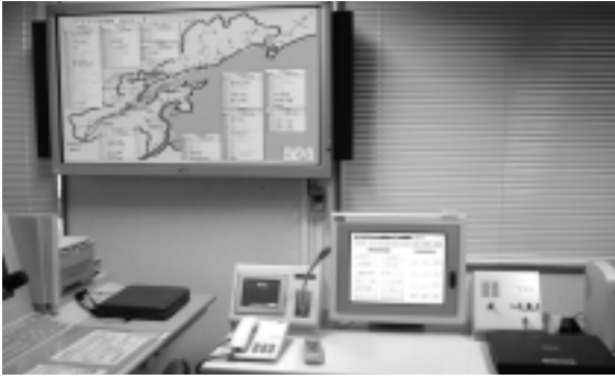
防災行政無線システム
