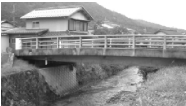
改修予定の堂ノ下橋
