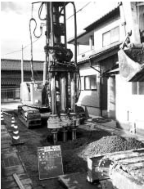
下水道工事風景
