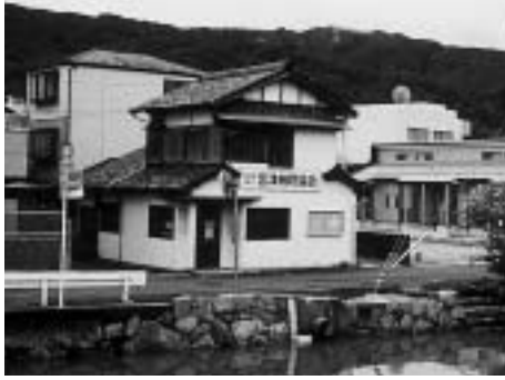
大手川改修に伴い移転される市有建物
