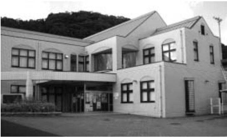
養老地区避難所に指定されている公民館
