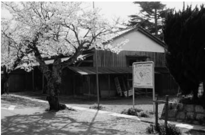
由良診療所建設予定地(旧由良JA倉庫)
