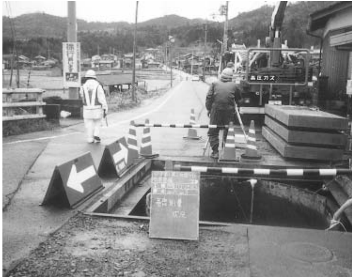
下水道工事風景
