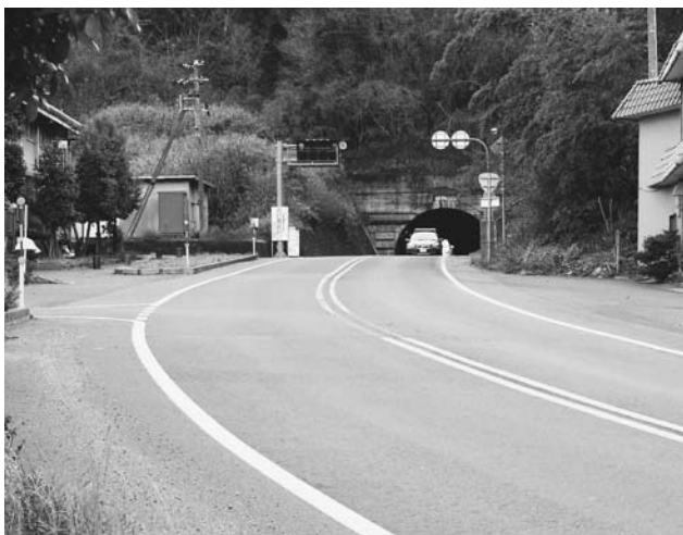
栗田トンネル出入口付近
