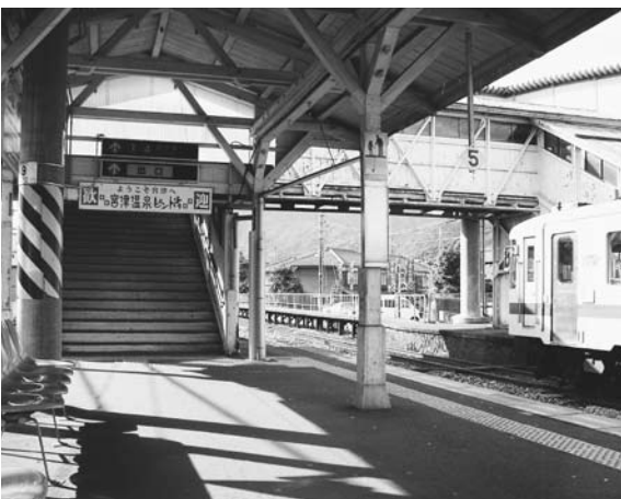
改良が望まれる宮津駅の袴線橋
