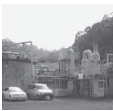
改修が必要なし尿処理施設
