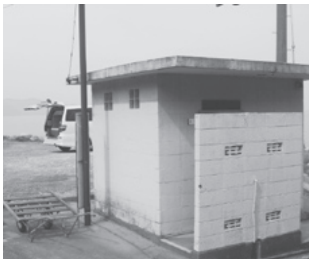
閉鎖された里波見公衆トイレ
