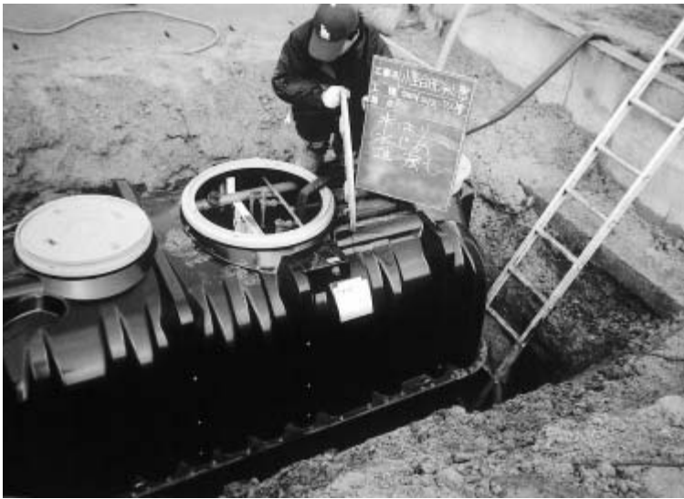
合併処理浄化槽設置工事風景
