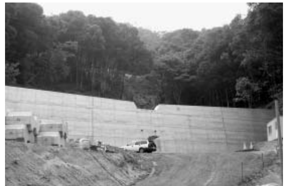
滝馬地区の砂防工事
