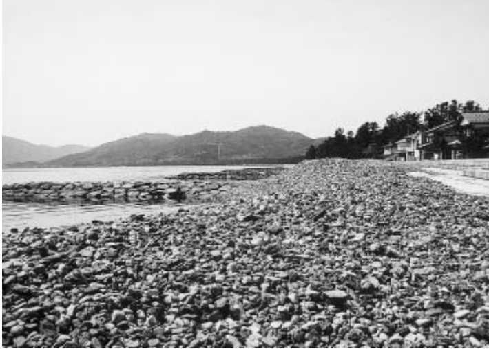
台風の波で打ち上げられた丸石
