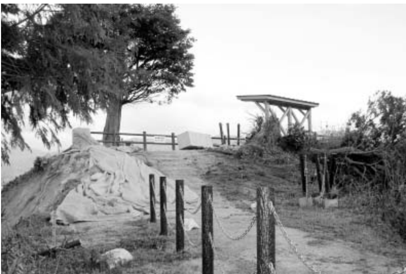
台風23号の被害を受けた大黒山公園展望台
