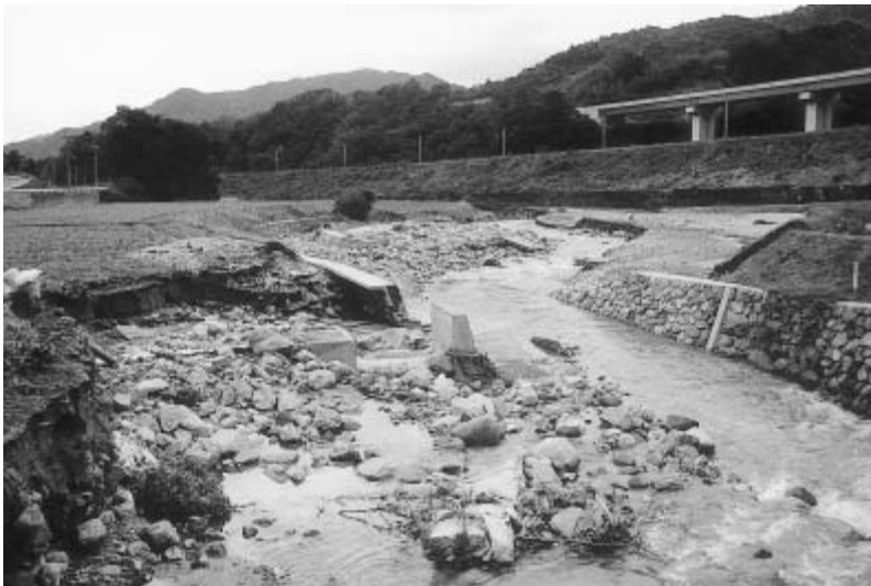
被害を受けた上宮津地区の河川
