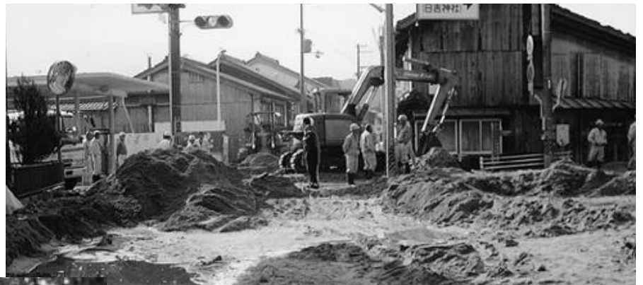
道路に堆積した土砂の除去作業（川向地区）
