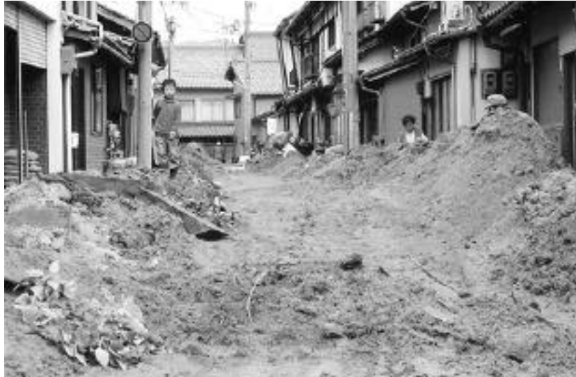
道路に堆積した土砂（蛭子地区）
