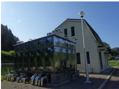
写真 2-4 波見谷浄水場（平成29年度 （2017年度）建設）
