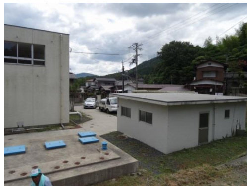
写真 2-5 滝馬浄水場（平成28年度 （2016年度）改修）
