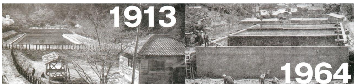
写真 1-1 給水開始（大正2年（1913年））当時の滝上浄水場（左図）と昭和39年（1964年）当時の滝上浄水場建設工事の様子（右図）
