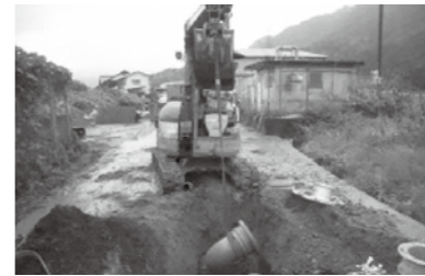
水道管の布設替え工事
