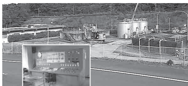
上宮津浄水場
