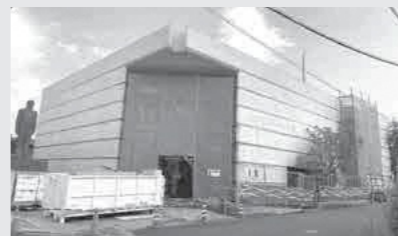
工事中のクロスワークセンター
